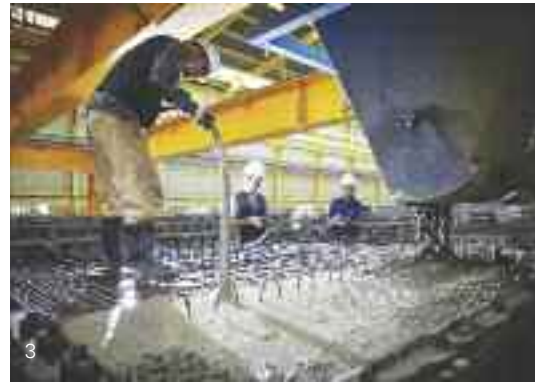
3. 타설 중인 콘크리트 제품관리를 하고 있는 고옥환 주임.
