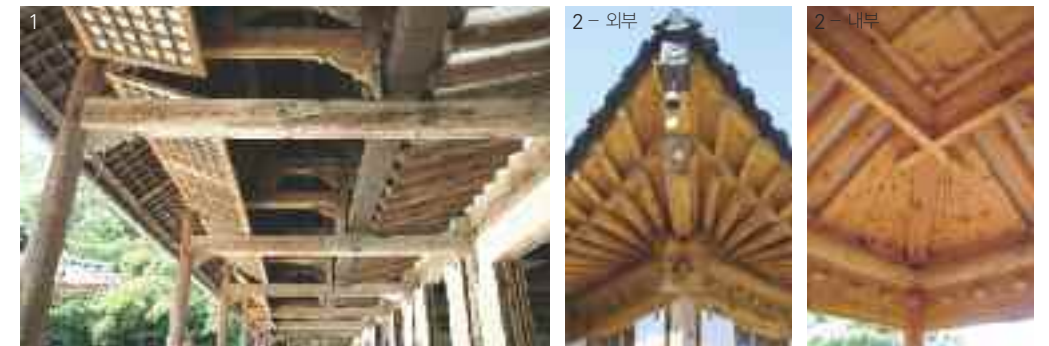
1. 서향하여 여름철 해질 무렵에 실내로 깊이 들어오는 햇빛을 막기 위해 설치한 차양과 창호 형태의 발 - 창덕궁 연경당의 서재인 선향재 2. 고난도의 기술을 필요로 하는 선자서까래의 외부(좌)와 내부(우) - 2000년도에 신축한 강화도의 주택, 학사재
